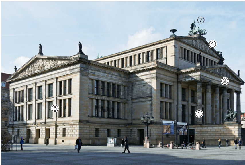
Das Schauspielhaus in Berlin zeigt alle Merkmale eines klassizistischen Bauwerks.
